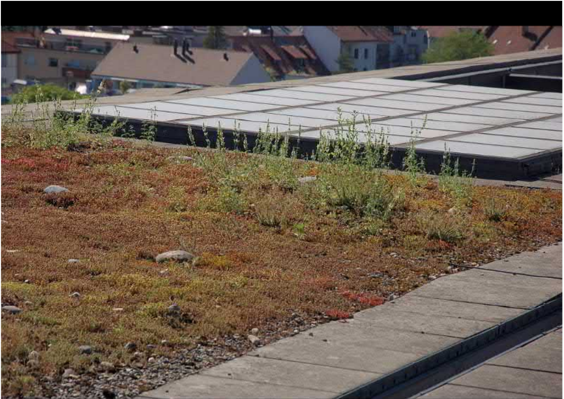
Basel, Dach Klinikum 1, Universitätsspital
