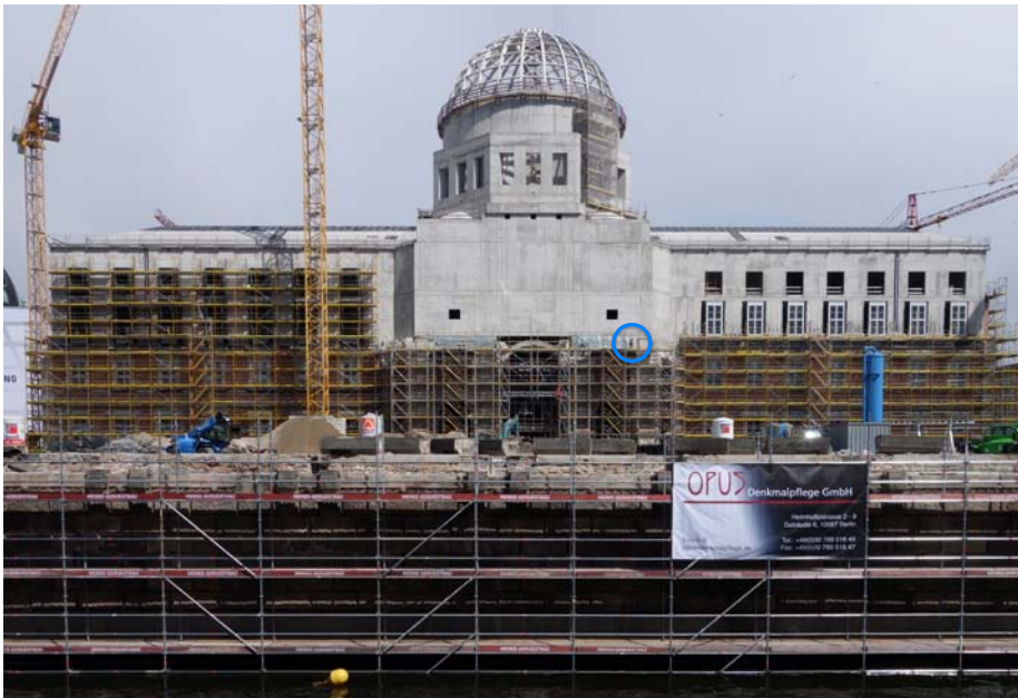
Berliner Stadtschloss (2016, Betonkern mit Faksimilefassaden; im blauen Kreis ein Mann)
